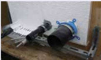
Das fertiggestellte Brandschott.
