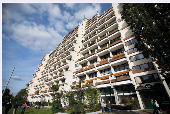
Dieser Hochhauskomplex (genannt Hannibal II) mit über 800 Personen wurde – vorsorglich bis zu seiner Sanierung – von der Behörde geräumt (Foto: dpa).
