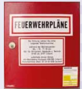
Feuerwehrplankasten, gesichert mit Feuerwehr-Plankastenschloss (Untersperre des Feuerwehrschlüsselsafe-Schlüssels nach Angabe der Feuerwehr oder Druckknopfmelder-Schlüssel).
