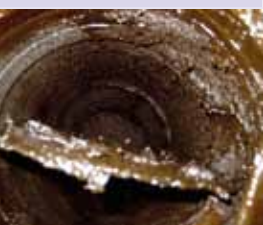
Klima- und Lüftungsanlagen zählen zu den sicherheitsrelevanten Einrichtungen.
