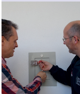
Bild 3: Bei Wartungsarbeiten ist das Öffnen des Safes nur nach dem Zwei-Hände-Prinzip möglich.
