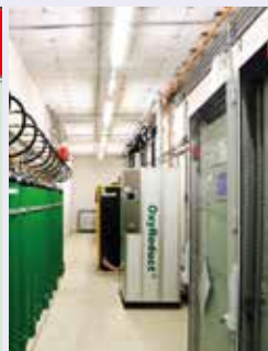
Oxyredukt – Sauerstoffreduktionsanlage (Quelle: Fa. Wagner).
