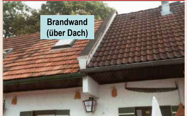
Überdachführung der Brandwand in einem Bauernhof.
