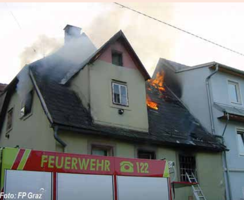
Ein Bild zur Frage der Brandabschnittsbildung (Foto: Feuerpolizei Graz).
