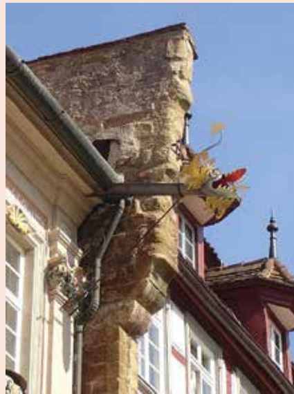
Ausgeprägter Ortgang als dekoratives bauliches Element in der Altstadt von Schwäbisch Hall.
