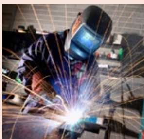
Große Brandgefahr bei Feuer- und Heißarbeiten (Bild E. Haim).
