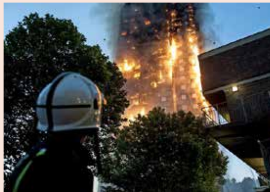
Der Großbrand im Londoner Grenfell Tower führte im Jahre 2017 auch bei uns zu einer umfassenden Diskussion über den Brandschutz in Hochhäusern.
