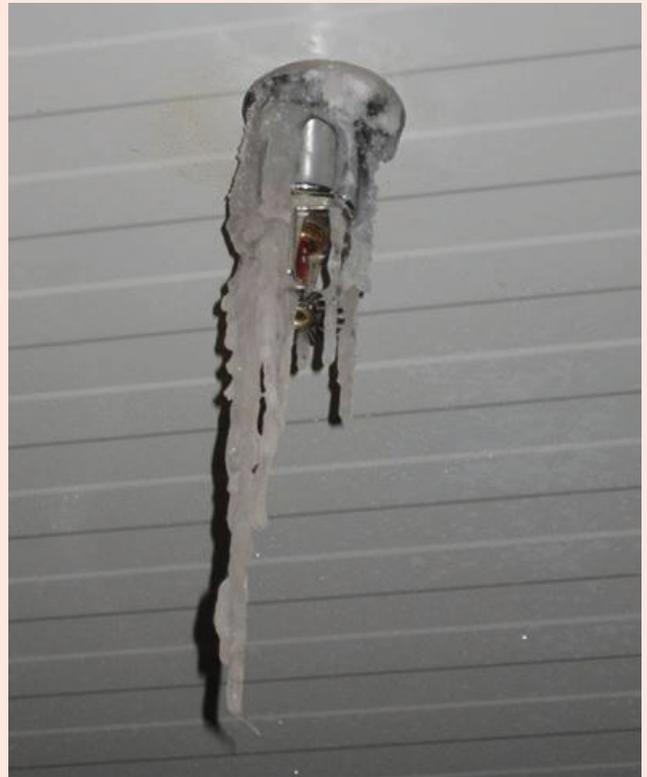
Kondensat auf einem Sprinklerkopf in einer Tiefkühlzelle (Bild: VdS).
