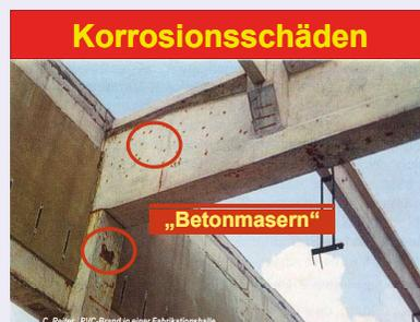
Korrosionsschäden an der Armierung einer Stahlbetonkonstruktion (Quelle: C. Reiter).
