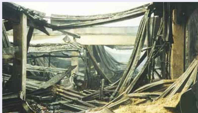
Großbrand aufgrund der mangelnden Kontrolle einer Feuerschutztüre.
